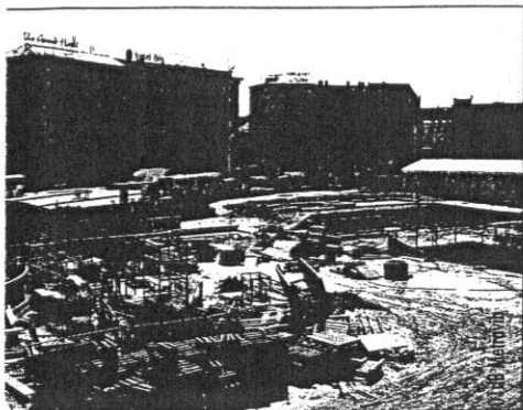
Photo 1 : La surveillance de l'environnement sonore est judicieuse aux abords des chantiers de construction et d'aménagement urbains.
